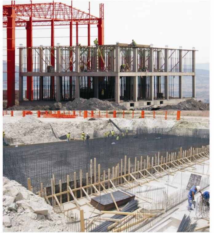
Konvansiyonel idari bina kısmında tüm betonarme karkas elemanlar ve bodrum katın perde izolasyonları tamamlanmıştır.
