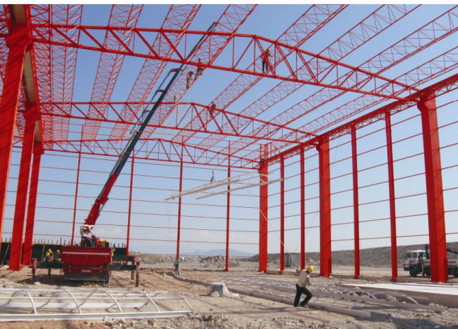
Atık Metal Döküm Üretim Tesislerin Yaklaşık 1.100 ton çelik yapı elemanları SİPİL Çelik Fabrikasında üretiliyor.
