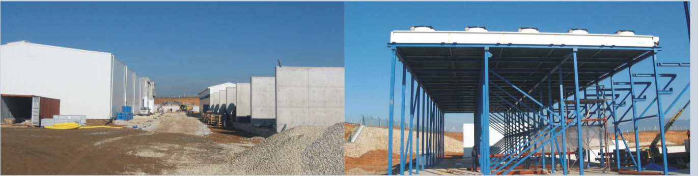
Yaklaşık 200 ton yapı çeliği ile imalatlarını tamamlayan SİPİL Çelik ekibi Finlandiya'lı motor üreticisi Wartsila bünyesindeki çelik üretim ve montajını da başarı ile tamamlamıştır.
