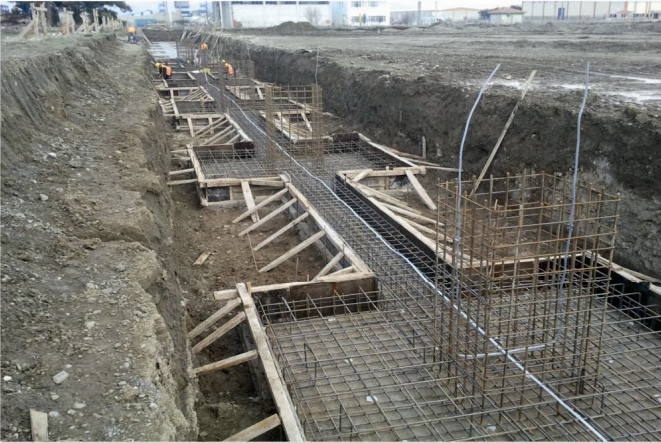
Tesislerde bulunan özellikli 3 adet makine temeli 60 günde makine montajına hazır hale getirilmiştir.
