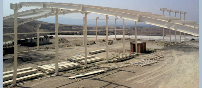
Denizciler Döküm fabrikasının 250 ton çelik yapıdan oluşan taşıyıcı sistemi SİPİL çelik tarafından üretiliyor.
