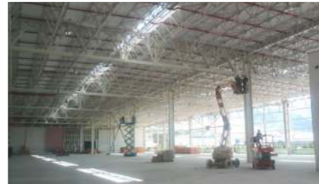
Toplam 11 bin m 2 kapalı alandan oluşan üretim ve depo binası taşıyıcı sistemi çelik yapı olarak projelendirilmiştir.
