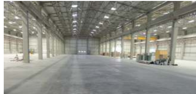
Form A.Ş. Fabrika ve Yönetim Binası taşıyıcı sistemi prefabrik kolon ve çelik çatı yapısal özellikleri taşımaktadır.
