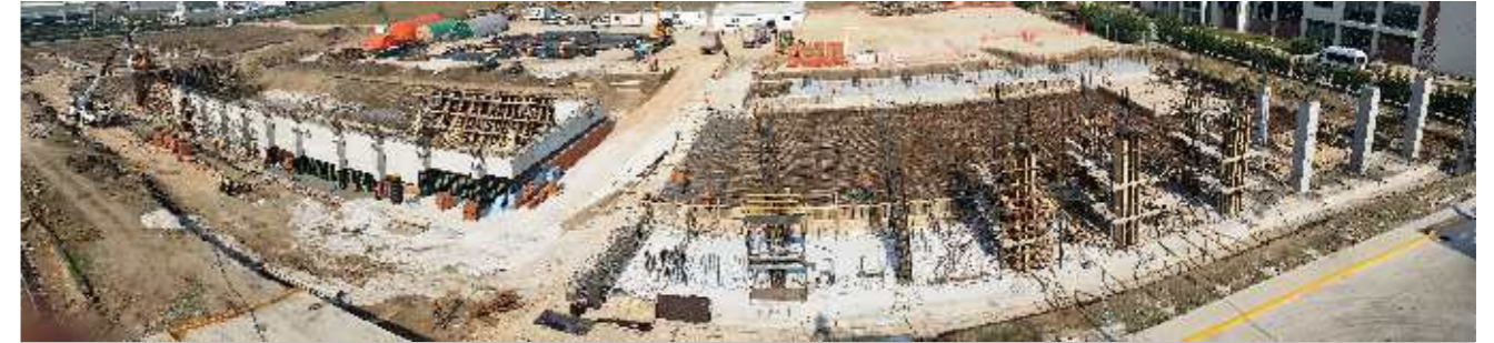
Kağıt Makinası temeli için yaklaşık 300 ton inşaat demiri kullanılmış ve 3 bin m 3 beton sürekli döküm ile durmaksızın 30 saatte tamamlanmıştır.
