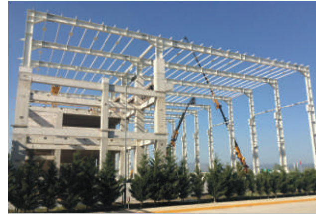
KM 4 Binasının çelik taşıyıcı sistemlerinin 29-21 aksı Sipil Çelik Grubunca imalatı ve montajı gerçekleştirilmiştir. Diğer imalatlar iş programına uygun bir şekilde sürmektedir.
