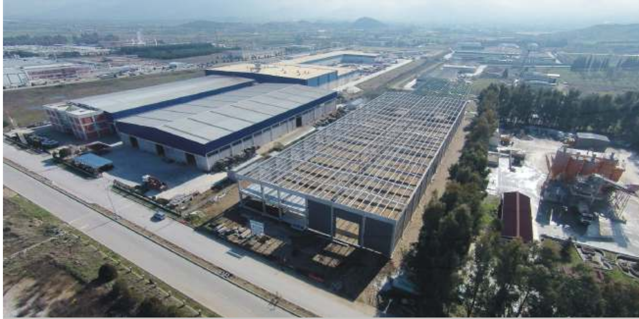
Tire OSB'de yer alan Sipil Çelik Tire tesisinin prefabrik yapı elemanı montajları tamamlandı.
